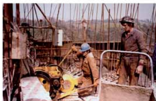
Tak je ta »zidarija« od zgora doj pa na zemlej vögledala. Zaprav, tak se je na zemlej začnilo raur gor postavlati. Zato, ka že prva so nut v živo skalo 13 mejterov duge pilote naprajli. Na tej cejli raur stodji.
