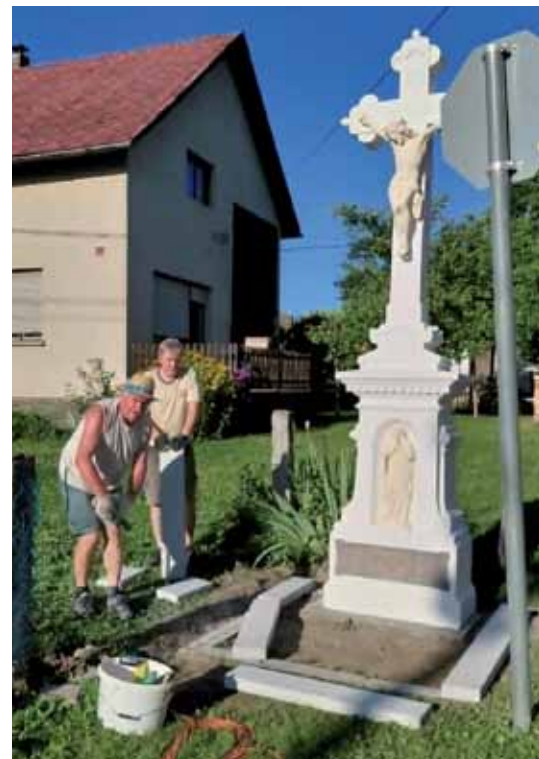
Obnovitvena dela so opravljali domači prostovoljci.
