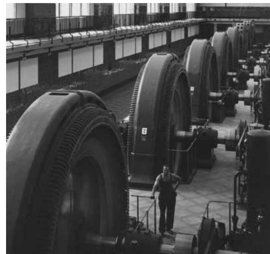
Agregate je sedem francis turbin poganjalo. Zaprav, voda iz Drave je turbine vrtejla, turbine aggregate, vö iz nji je elektrika šla.
