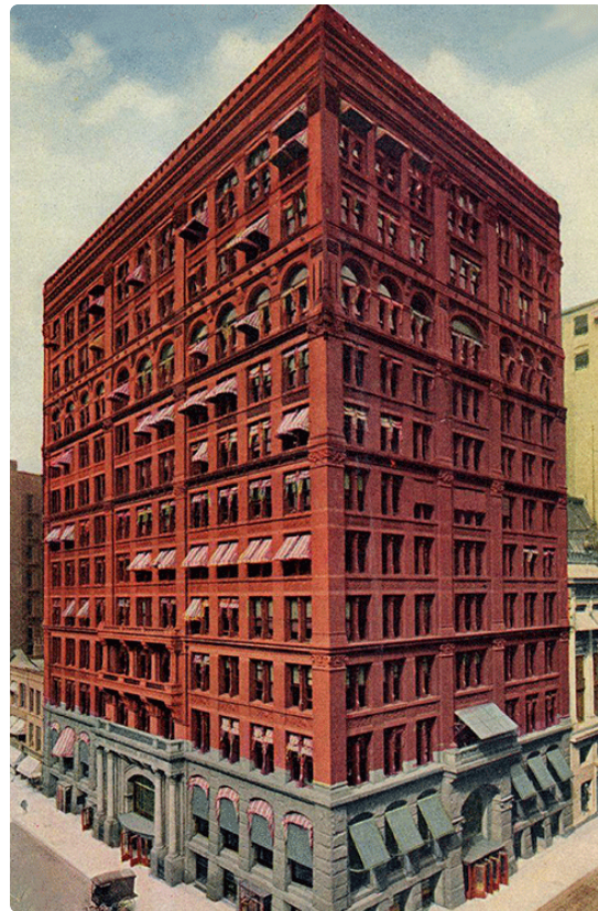
Prvi nebotičnik v Čikagoni je tak vögledo. Najprva so konstrukcijo iz železa naprajli, po tejm so nut cigle zozidali. Depa cigli v nebotičnikaj pomalek slobaud gemlejo, nauvi pa nauvi materiali naprej pridejo.
