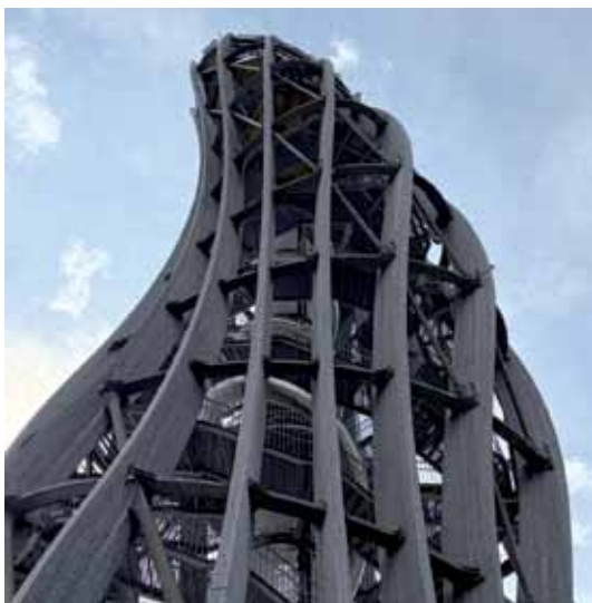
Ekstravagantna struktura razglednoga törma na Jedvovci je gratala simbol cejlje krajine kauli Celovca. Lift v pau minute zdigne najgir lüstvo na teraso na 70 mejteraj. Če ga nega, vandraše čaka 441 stub.
